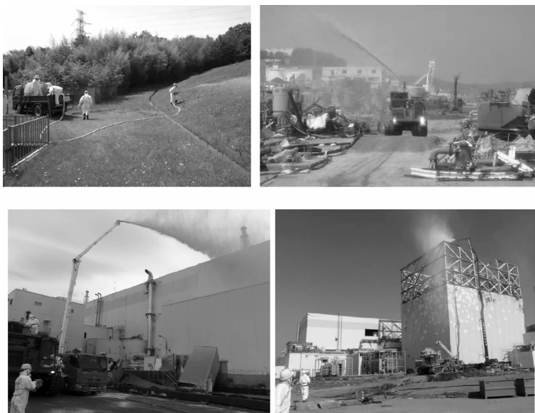
图 8 福岛核事故中向地面、道路和厂房喷洒沉积放射性的抑制剂
